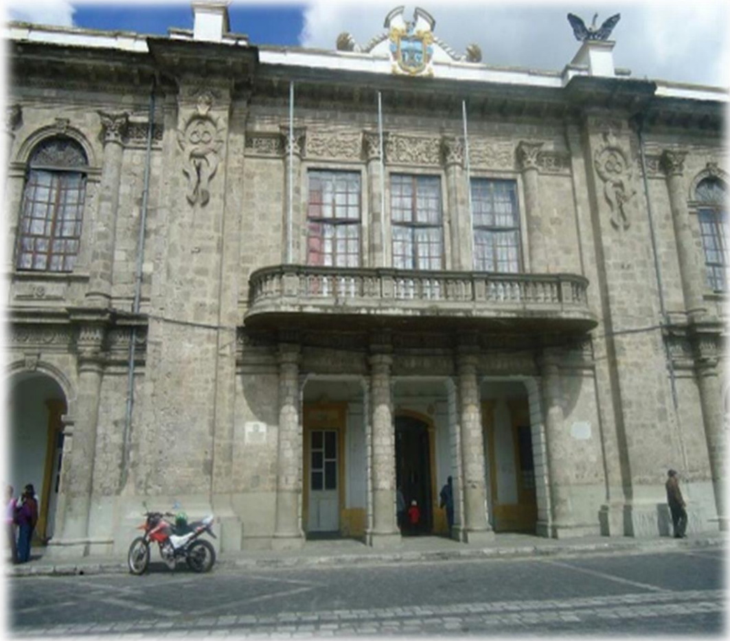
Fachada Principal del GAD municipal de la ciudad de Latacunga, ubicada en la parroquia La Matriz, en las calles Sánchez de Orellana y General Maldonado.
