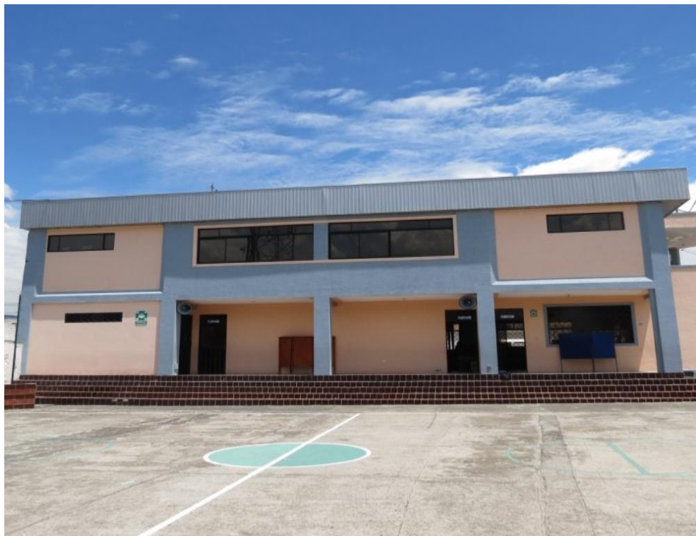
Aulas de la Institución
