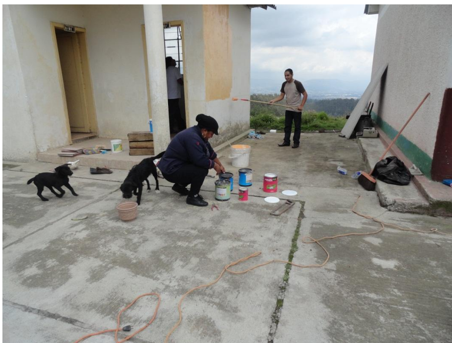
FOTO 3: PREPARACION DE LA PINTURA PARA EL INTERIOR
