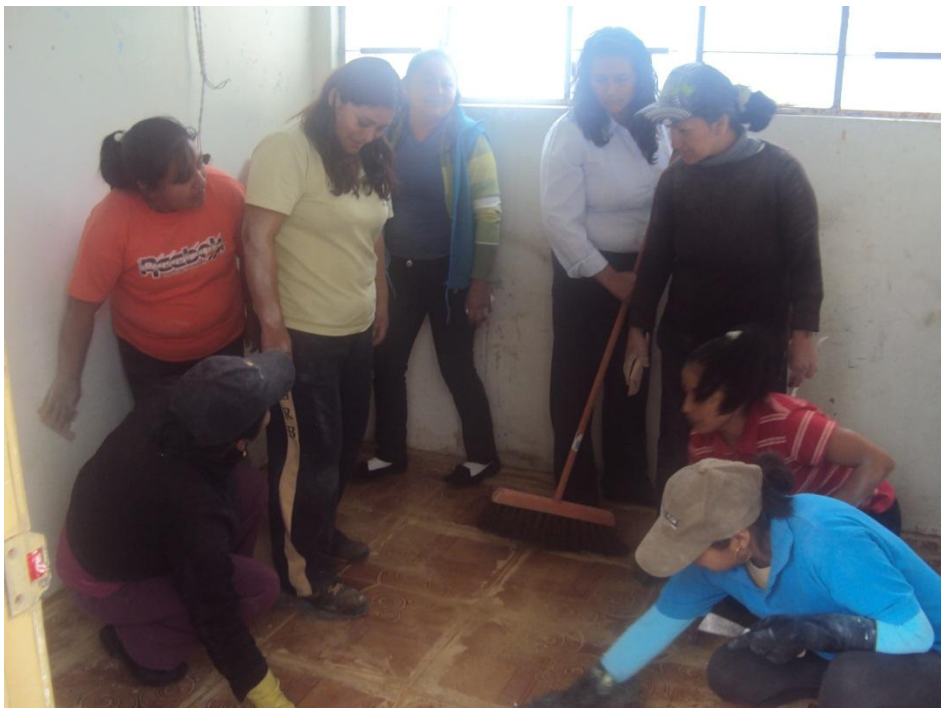
FOTO 2: REALIZANDO LA LIMPIEZA DEL INTERIOR DESPUES DE PONER LA BALDOSA
