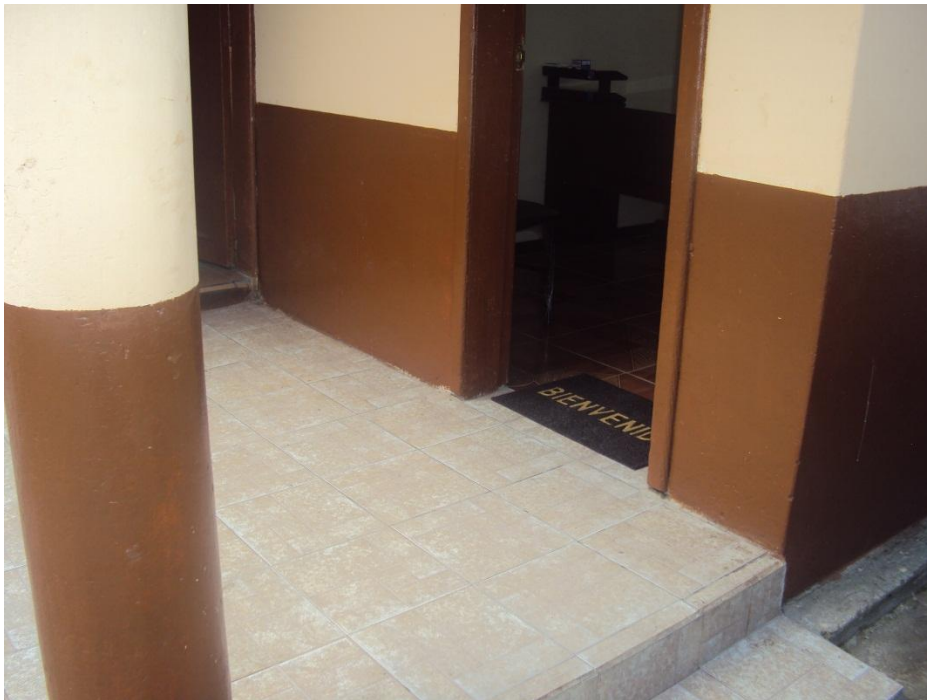
FOTO 4: FACHADA FRONTAL TERMINADA
