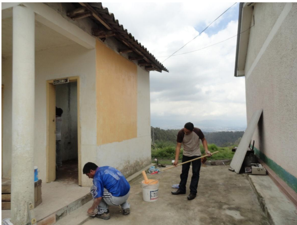
FOTO 2: COLOCACION DE LA BALDOSA EN LA PARTE EXTERNA.
