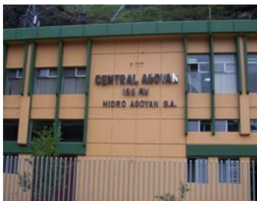
Figura 6.1 Casa de Máquinas de la Central Hidroeléctrica Agoyán (HIDROAGOYÁN)
