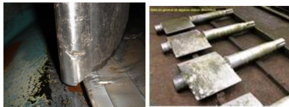
Figura 2.7 Álabes Directrices que Necesitan Reparación (HIDROAGOYÁN)
