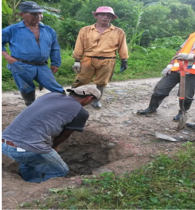
Gráfico N° 31. Excavación de calicata
