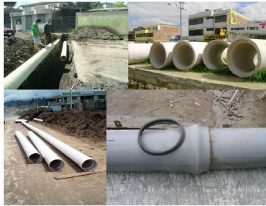
Gráfico N. 15 Tipos de tuberías de acuerdo al materia y al tipo de unión.
