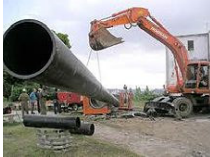
Gráfico N° 2.2: Instalación de Tuberías de Acueducto Fuente: "Ingeniería Sanitaria"
