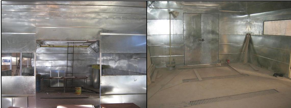
Figura 82: Colocación de las láminas de tol en la estructura
