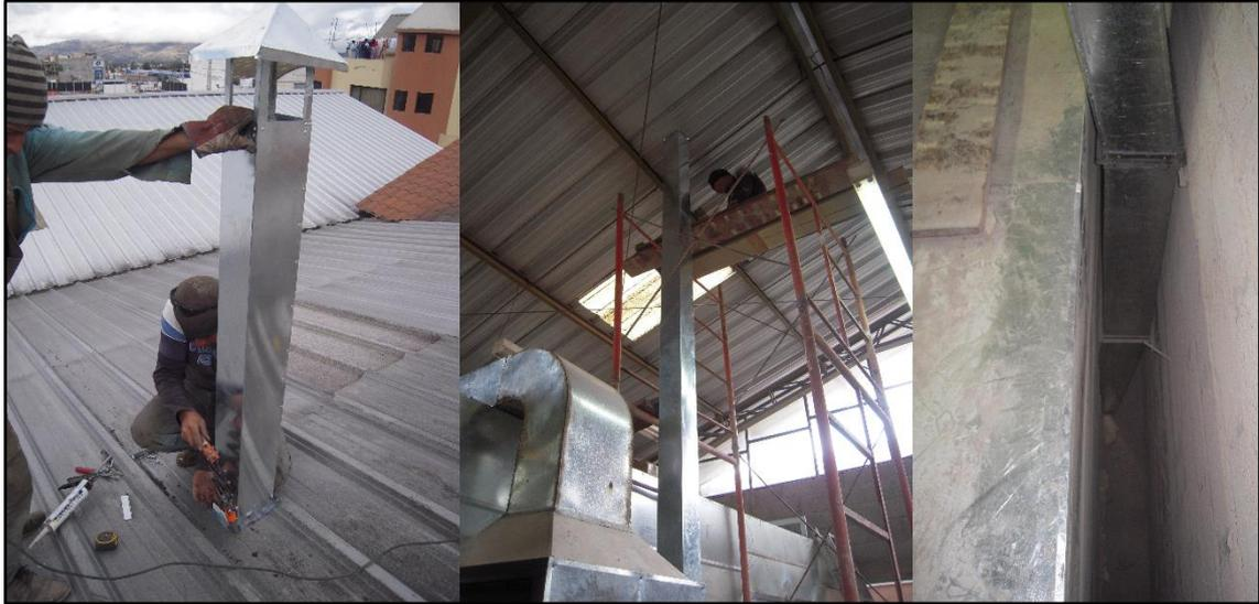
Figura 84: Ductos elaborados con planchas de acero galvanizado.
