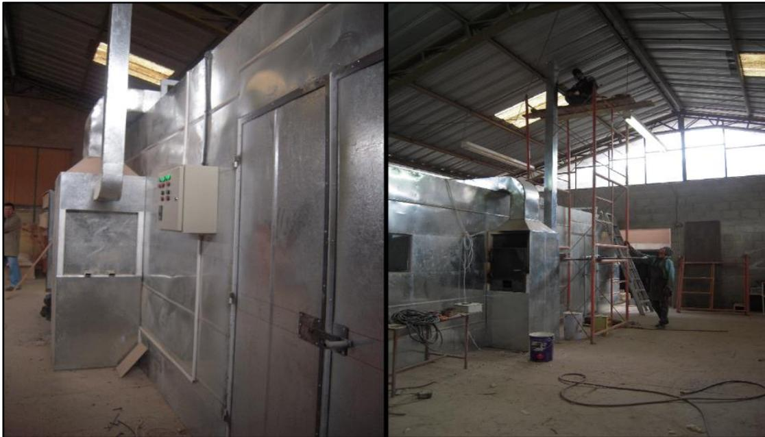
Figura 86: Instalación del generador de aire caliente
