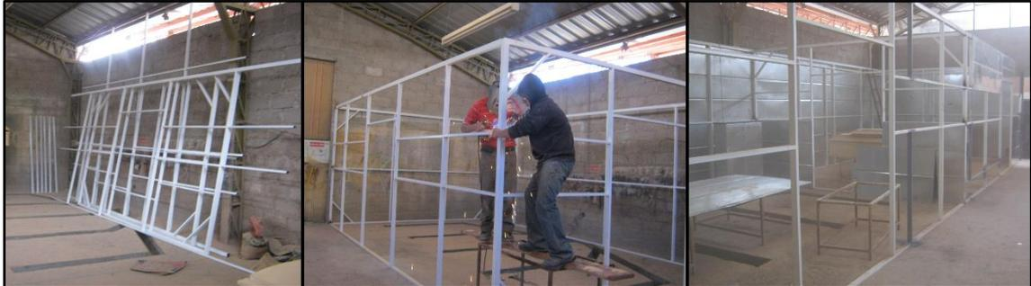
Figura 80: Estructura ensamblada de las cámaras de pintura y secado.
