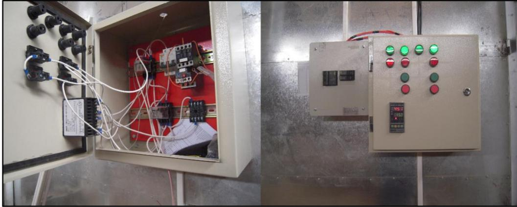
Figura 87: Instalación del panel de control de la cámara de secado y del sistema de ventilación
