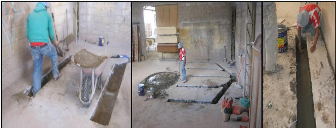
Figura 77: Construcción de las fosas de a cámara de pintura
