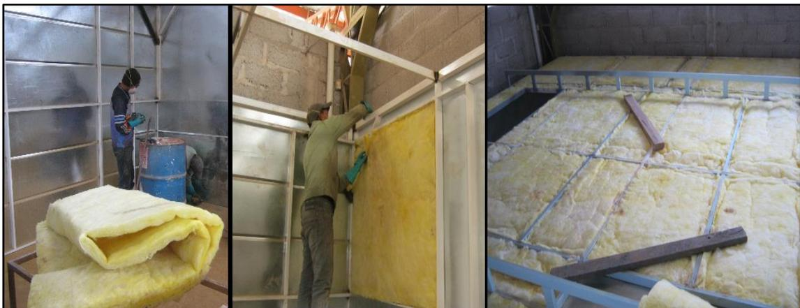
Figura 81: Aislamiento de paredes y techo de la estructura
