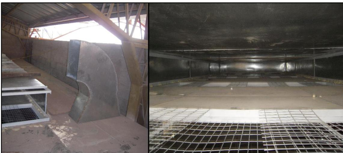
Figura 83: Ducto y plenum de la cámara de pintura
