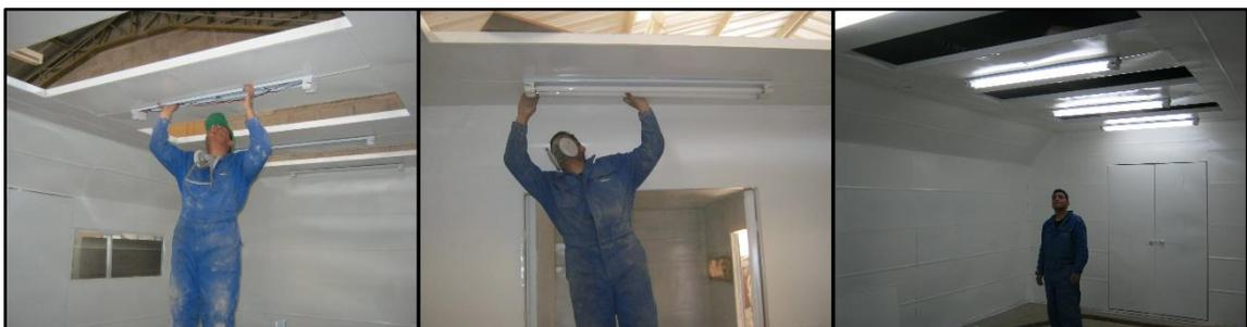
Figura 88: Instalación de luminarias
