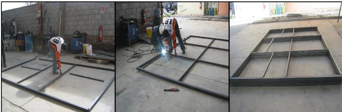
Figura 79: Construcción estructura de paredes y techo
