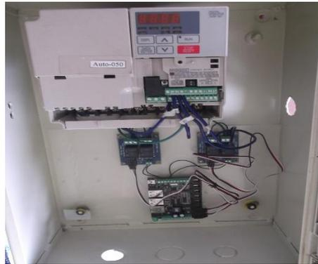
**Figura 6.44** Conexión variador de frecuencia
