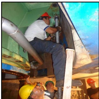
y) Desmontaje de espárragos de la tapa inferior - Izaje de la tapa al piso de maniobras z) Rodete desmontado
