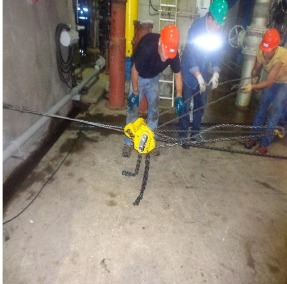
a) Inspección del desmontaje del rodete
