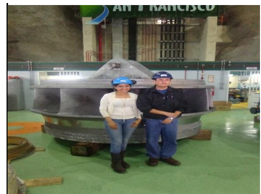
g) Rodete desmontado para mantenimiento
