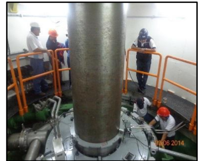
c) Verificando la apertura y cierre de álabes
