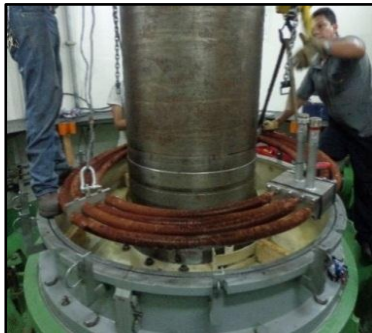
m) Desmontaje del serpentín del cojinete de turbina
