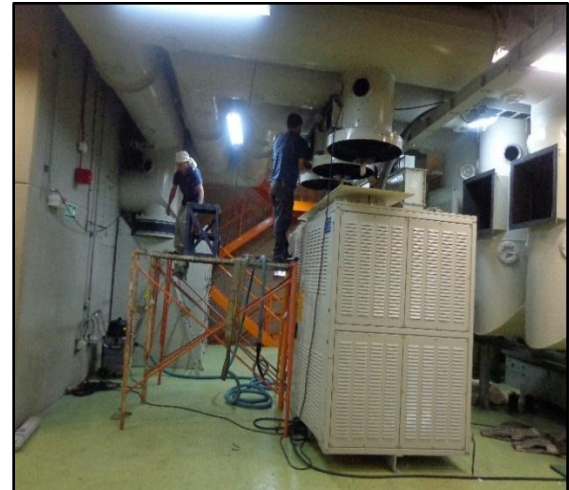
g) Mantenimiento de Transformadores de corriente a la salida del transformador auxiliar
