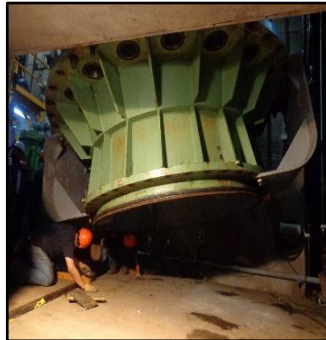
y) Desmontaje de espárragos de la tapa inferior - Izaje de la tapa al piso de maniobras z) Rodete desmontado
