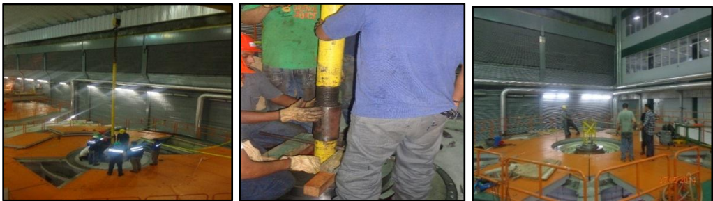
b) Dispositivo para bajar el rodete hasta la succión
