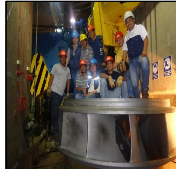
y) Desmontaje de espárragos de la tapa inferior - Izaje de la tapa al piso de maniobras z) Rodete desmontado
