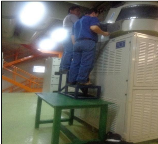
g) Mantenimiento de Transformadores de corriente a la salida del transformador auxiliar
