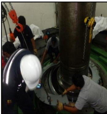
k) Desmontaje del cojinete de turbina
