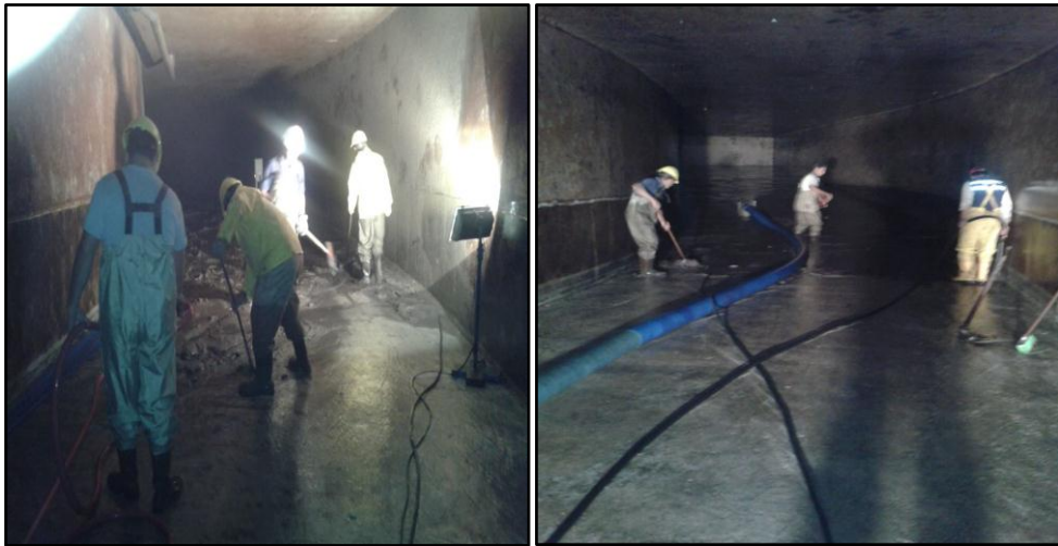
b) Limpieza del tanque de bombeo
