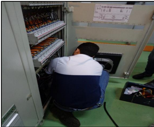
c) Mantenimiento de Cargadores de Baterías de 125 VCC. TCB-125 1/2/3
