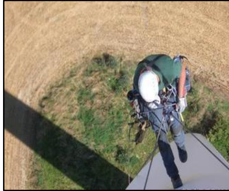
Fig. 19 Sistema de acceso mediante cuerda [70]
