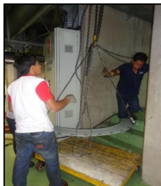
o) Desmontaje del sello de agua
