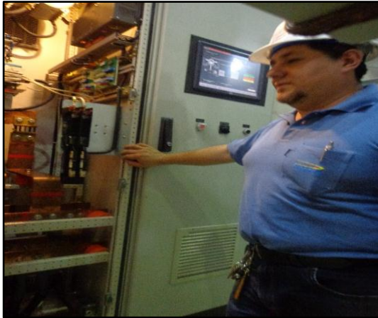
a) Mantenimiento del Regulador de Voltaje RAV
