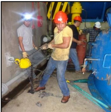
v) Desmontaje de la tubería de succión w) Tapa inferior desmontada x) Gatos para bajar la tapa inferior
