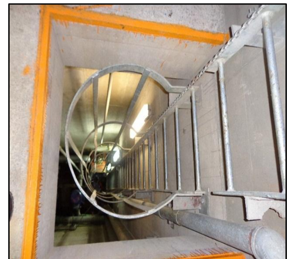
i) Pozo de vaciado
