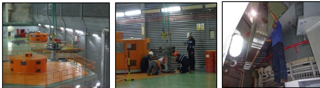
h) Desmontaje de los anillos de las escobillas
