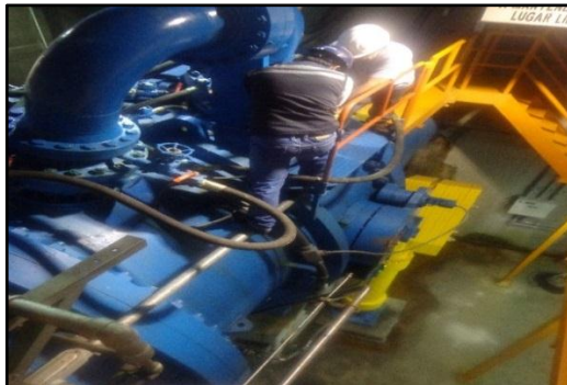
d) Limpieza de las cámaras válvulas by-pass
