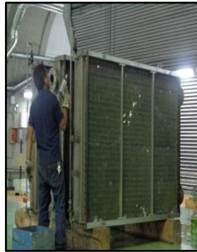
i) Limpieza de los intercambiadores de calor
