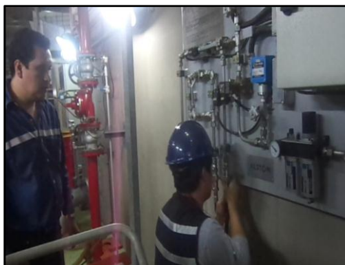
f) Aplicación y des aplicación de frenos o Levantamiento del rotor con bomba manual
