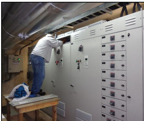
d) Mantenimiento de Tableros Variadores de frecuencia de 480 VCA de BF9XX del NTSAE.
