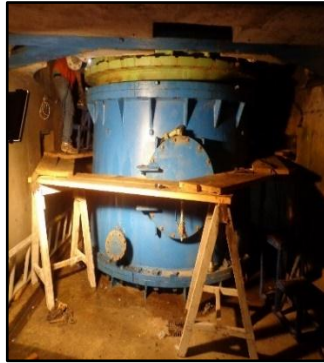
s) Desmontaje de la succión t) Plataforma para retirar los bujes u) Desmontaje de la tapa inferior
