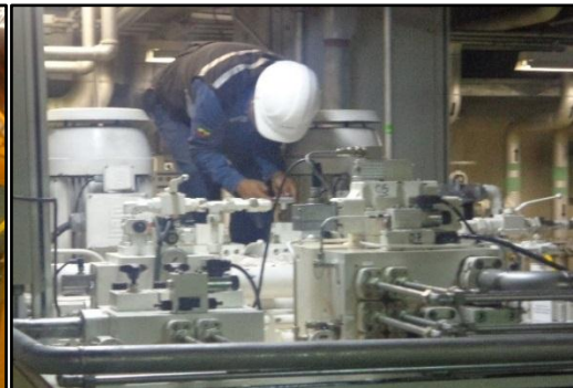
e) Despresurización de la PUH
