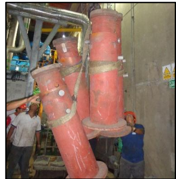
v) Desmontaje de la tubería de succión w) Tapa inferior desmontada x) Gatos para bajar la tapa inferior
