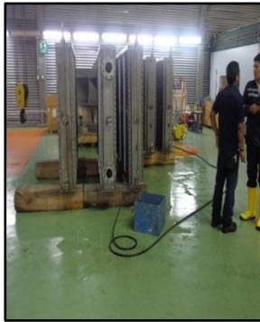
i) Limpieza de los intercambiadores de calor
