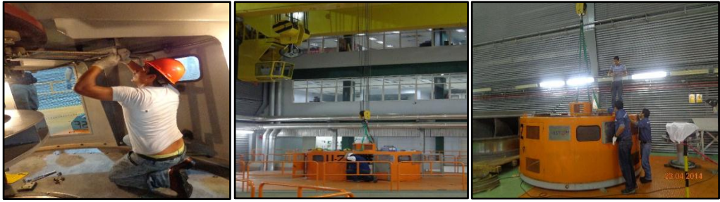
a) Limpieza de escobillas - Desmontaje de Escobillas y Tapa de protección del Recinto de Escobillas.
