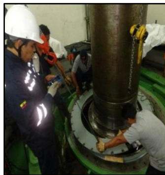
k) Desmontaje del cojinete de turbina
