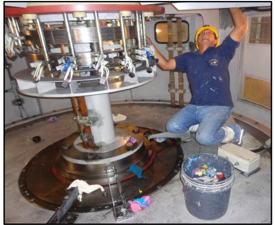
b) Mantenimiento del recinto escobillas
