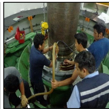
l) Retirando el aceite del cojinete turbina
