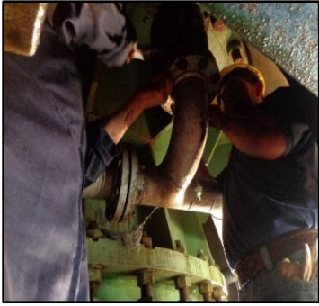
q) Desmontaje de la válvula de aireación de la caja espiral r) Desmontaje de espárragos de la tapa inferior
