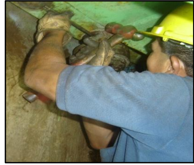
q) Desmontaje de la válvula de aireación de la caja espiral r) Desmontaje de espárragos de la tapa inferior
