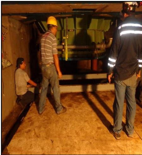
e) Colocación de plataforma móvil para el desmontaje de la tapa inferior
