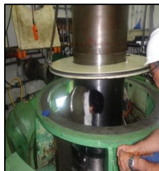
n) Desmontaje de cuba de aceite del cojinete de turbina
