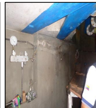
p) Desmontaje de la tubería y manómetro de la succión
