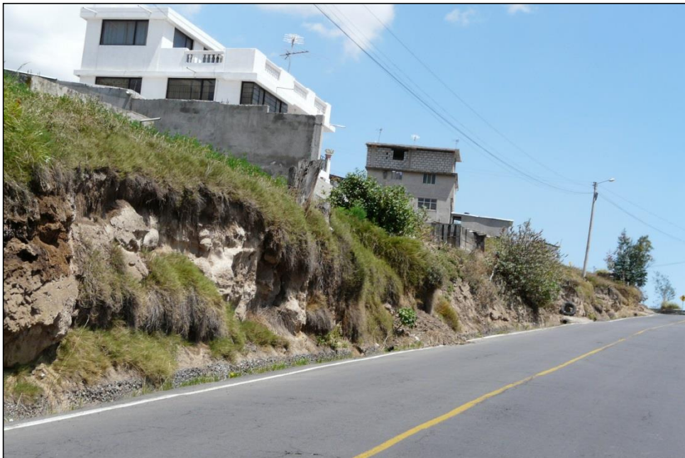
Abscisa 0+550m. Desprendimiento en hormigón de cunetas.
