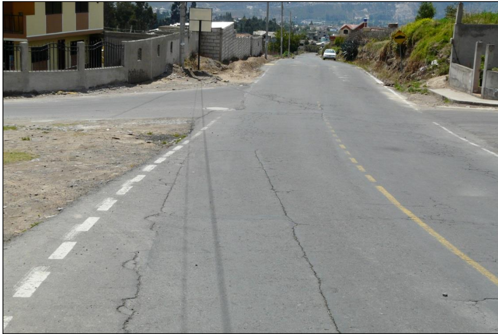
Abscisa 0+500m. Intersección con vías alternas y trabajos de parcheo.
