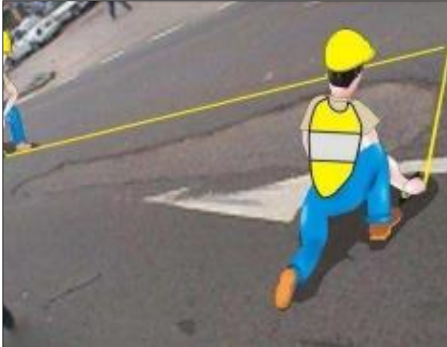
Gráfico 13 Descascaramiento, pérdida de la última capa de rodadura.
