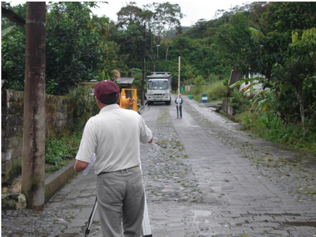
Nivelación de líneas de alcantarillado
