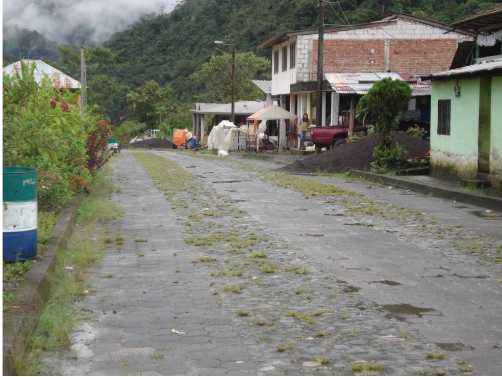
Vías de Acceso características del sector
