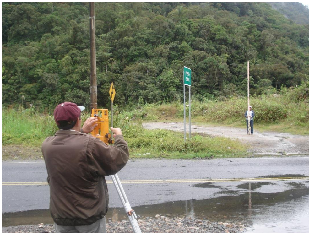
Levantamiento Topográfico en el sitio donde se ubicara la Planta de tratamiento
