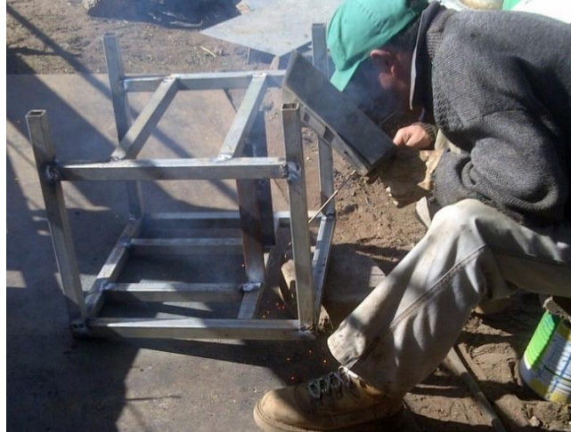
Figura 6.6: Construcción de la mesa FUENTE: Roberto C. Panimboza C. (Autor)
