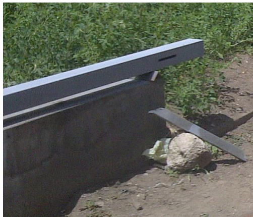
Figura 6.9: Construcción del brazo FUENTE: Roberto C. Panimboza C. (Autor)
