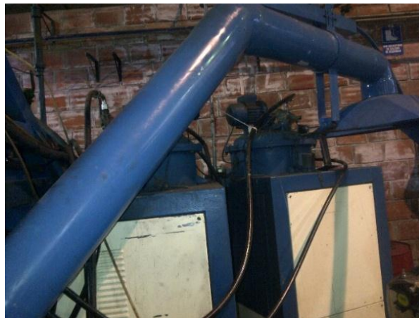
Figura 6.18: Ensamble del ducto FUENTE: Roberto C. Panimboza C. (Autor)
