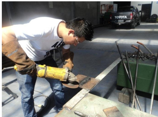
Figura 6. 37.- Pulido de la soldadura
