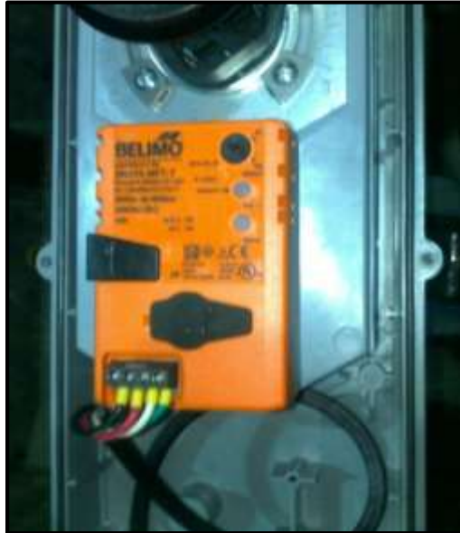
Figura 4.69 Conexión de válvula
