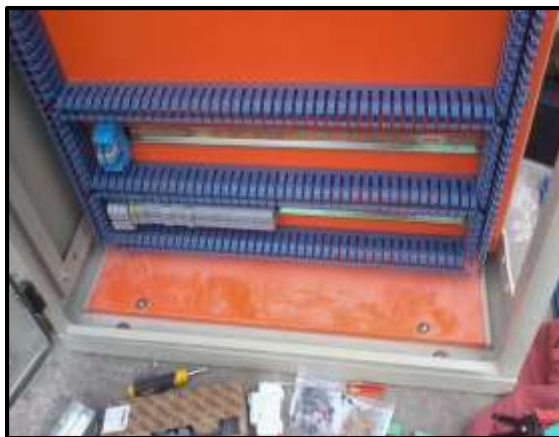
Figura 4.62 Colocación de riel DIN y canaleta
