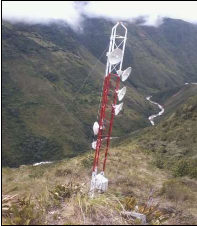
Figura 4.85 Colocación de antenas repetidora El Tablón
