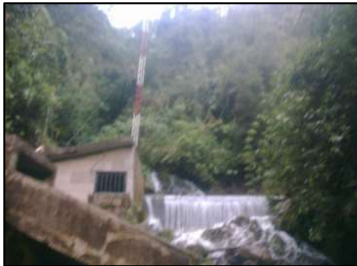
Figura 4.83 Colocación torre Captación
