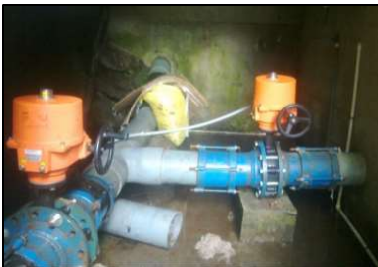
Figura 4.33 Colocación de válvulas Captación
