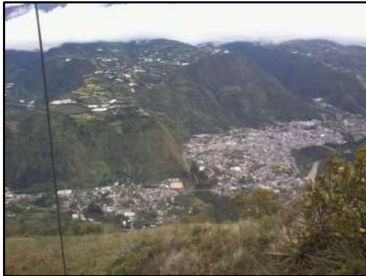
Figura 4.10 Vista El Tablón – Baños de Agua Santa
