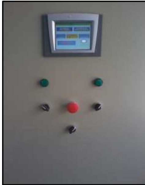
Figura 4.102 Tablero del tanque El Panecillo
