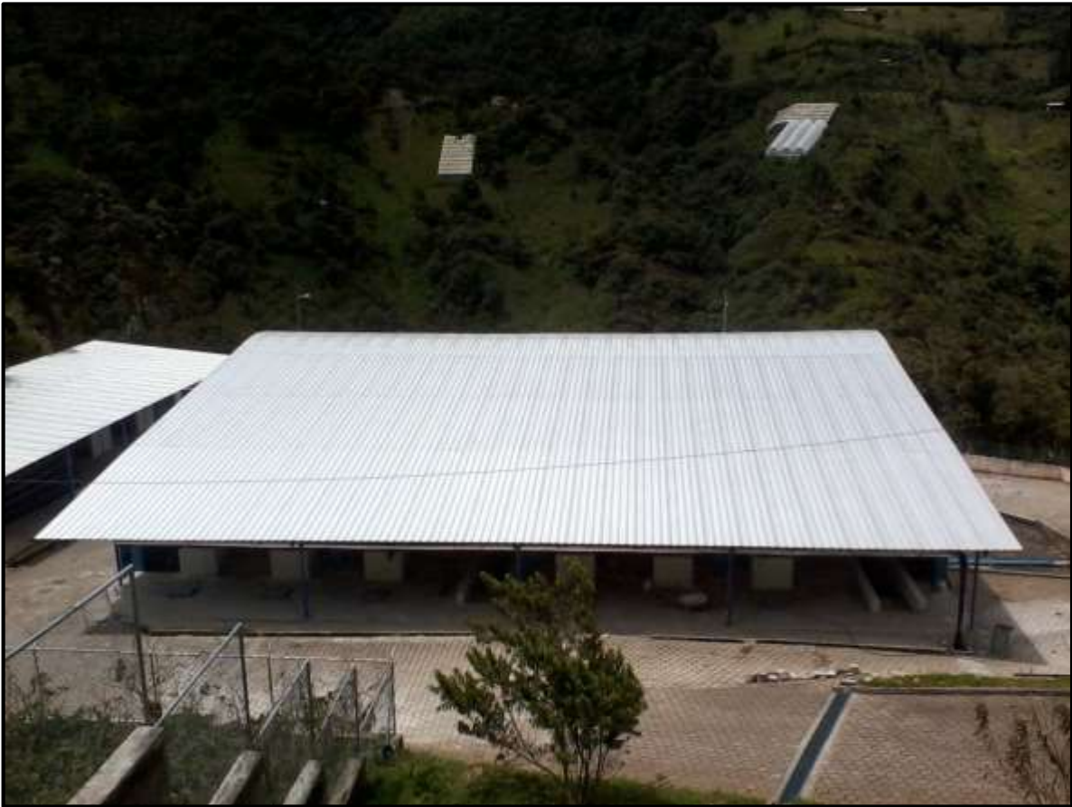
Figura 4.1 Planta de Tratamiento
