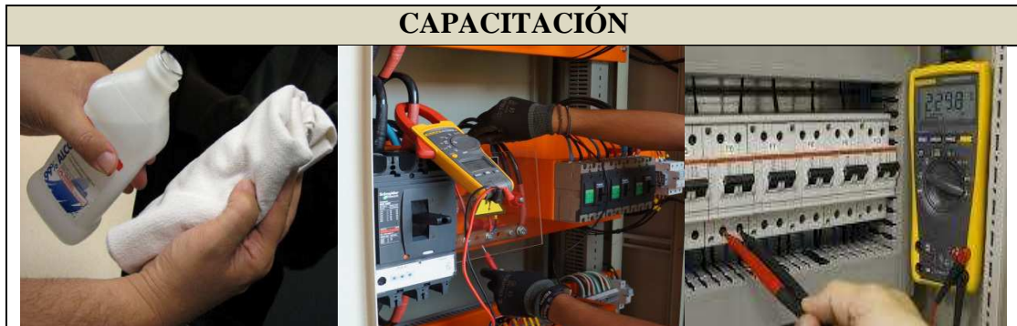
Foto 27: LIMPIEZA CON ALCOHOL ISOPROPÍLICO, MEDICIÓN DE CORRIENTE AMPERÍMETRO DE PINZA Y USO DEL MULTÍMETRO
