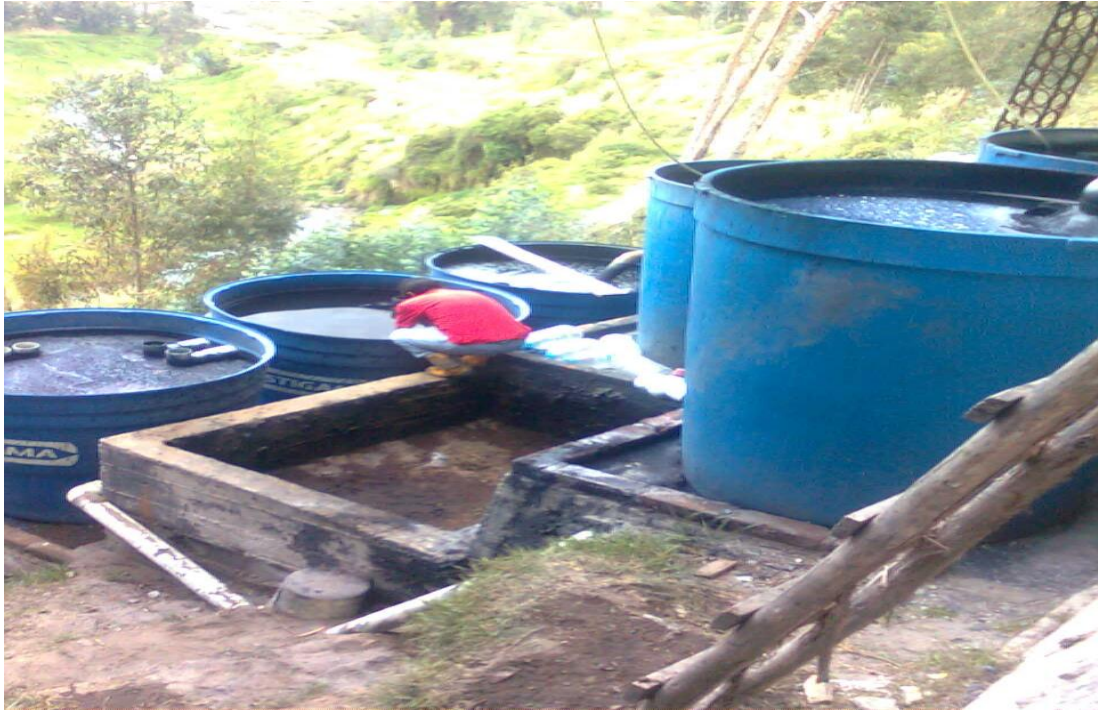
Imagen F-6: Planta de tratamiento del agua residual del Jeans
