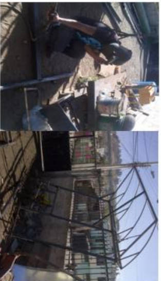
UNION DE PIEZAS Y ARMADO DE ESTRUCTURA DE LA PARADA
