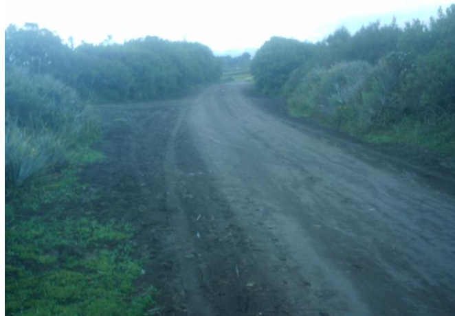
Fotografía N° 4 Final abscisa 10+403,86 – sector Miraflores
