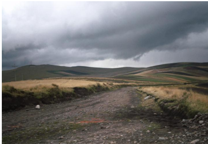
Fotografía N° 2 Recorrido de la vía
