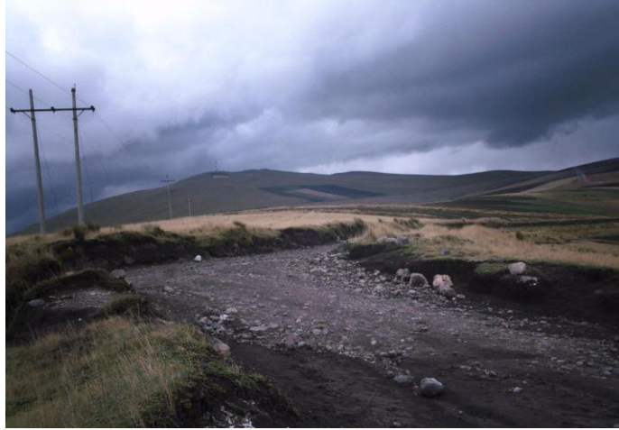
Fotografía N° 3 Recorrido de la vía
