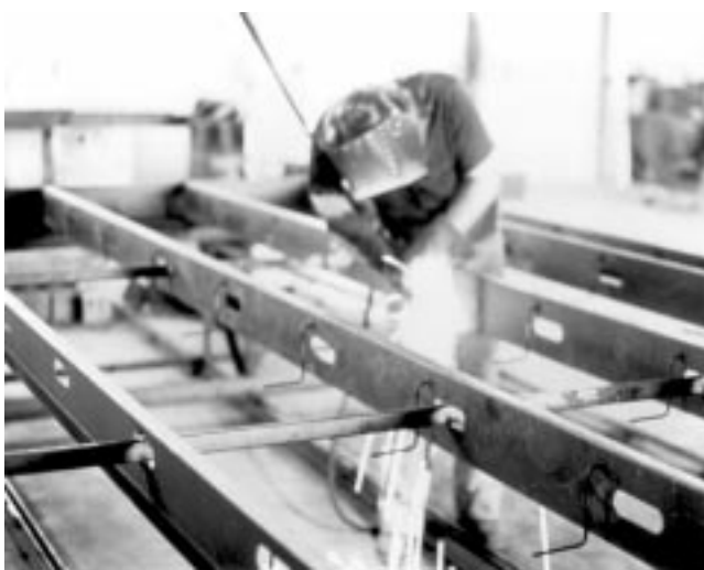
Fig. 3.12—Fabrication of steel-stud frame
