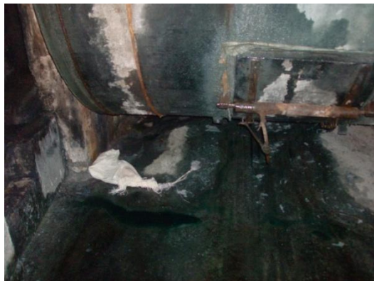
Figura 16: Riesgo Mecánico: Piso Resbaladizo en el Proceso Curtición Fuente: El Investigador
