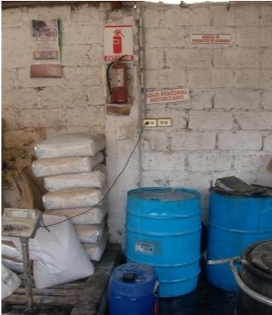
Desorden y obstáculos para utilizar el extintor.
