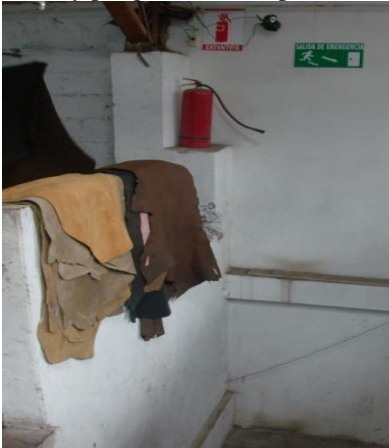
Desnivel y peligro de caídas para utilizar el extintor.
