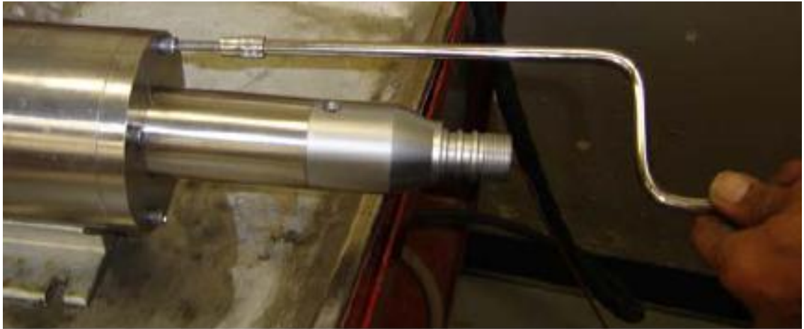
Figura N° 6.6.3.3.1h) Colocación del split ring en la control valve.
