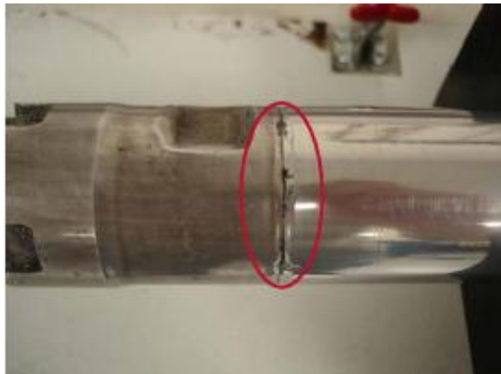
Figura N° 6.6.3.2.1 i) Inspección de lavados en el chasis de la CMS.
