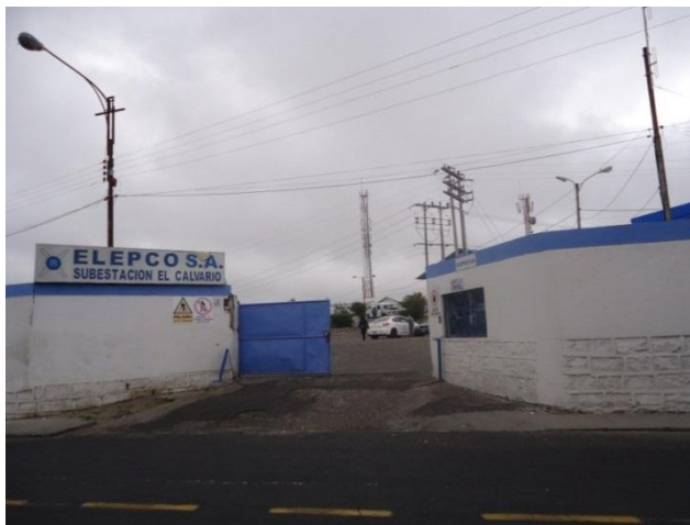
Figura 6.61: Fachada de la subestación El Calvario Elaborador por: El Investigador
