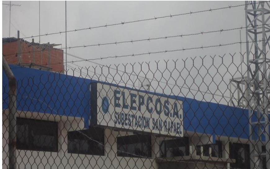
Figura 6.64: Fachada de la subestación San Rafael Elaborador por: El Investigador
