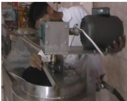
5. Instalación del sistema de batido (3)
