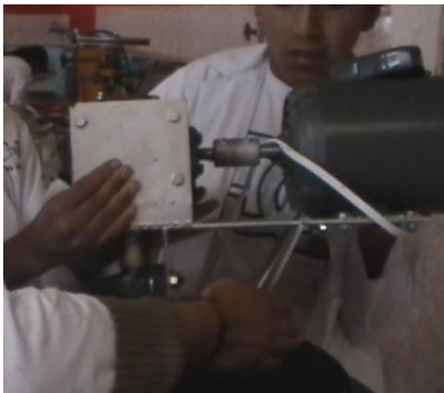
2. Instalación del sistema de batido (1)
