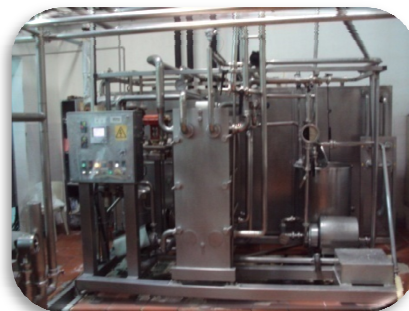
Figura 6.6: Limpieza de equipos
