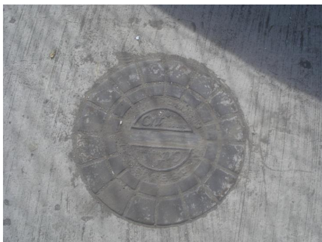
Figura 40. Canalización en las calles y aceras.
