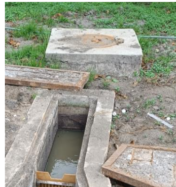
Figura 22. Izquierda: tanque de distribución. Derecha: tanque de distribución 2.
