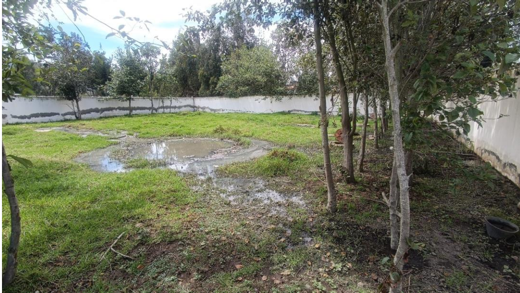
Figura 11. PTAR inundada en temporadas lluviosas.
