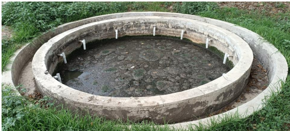
Figura 33. Tanque sedimentador, foto real.
