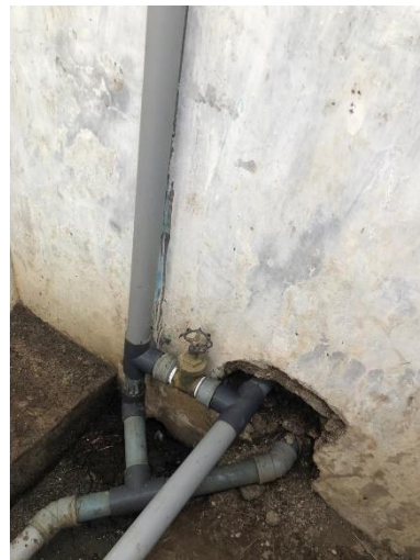
Inspección de los componentes
