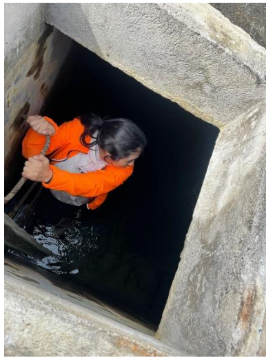
Inspección del tanque de distribución
