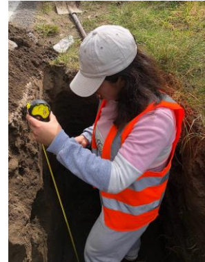
Descripción: Medición de la profundidad de la calicata.
