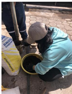
Descripción: Realización del ensayo CBR.
