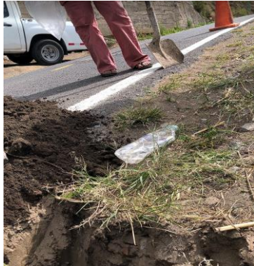
Descripción: Realización de calicatas.
