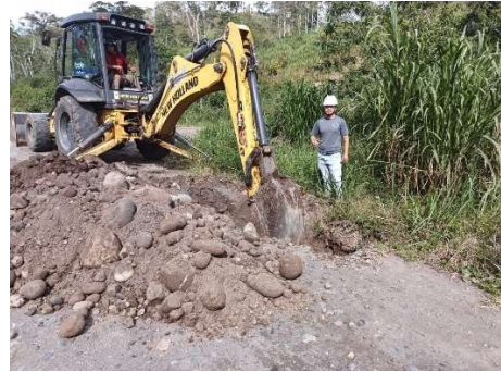
Apertura de calicatas
