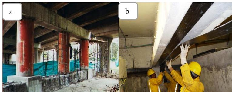
**Figura 1.2** Técnicas no convencionales: a) Encasamiento en acero. b) Encasamiento materiales compuestos FRP [23].
