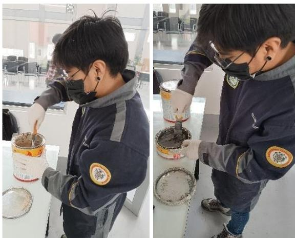
6. Pesar los componentes para la mezcla en porción 3:1 de resina.
