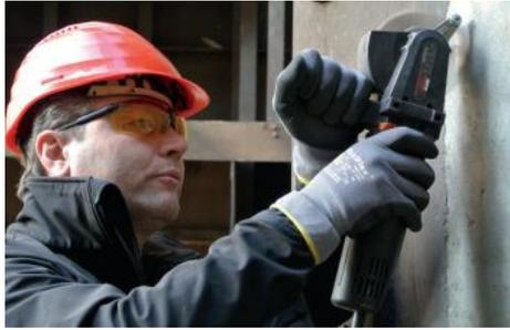
**Figura 1.22** Proceso de preparación de superficie por cepillo abrasivo [53].
