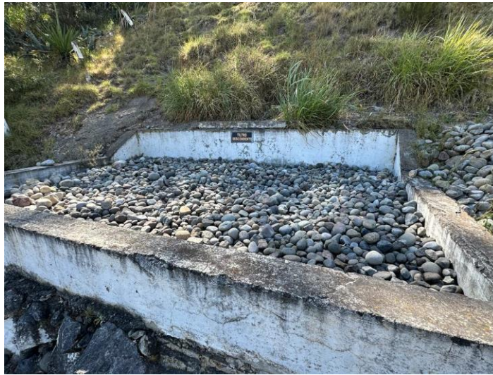
Figura 22. Filtro Descendente. Fuente: Autor
