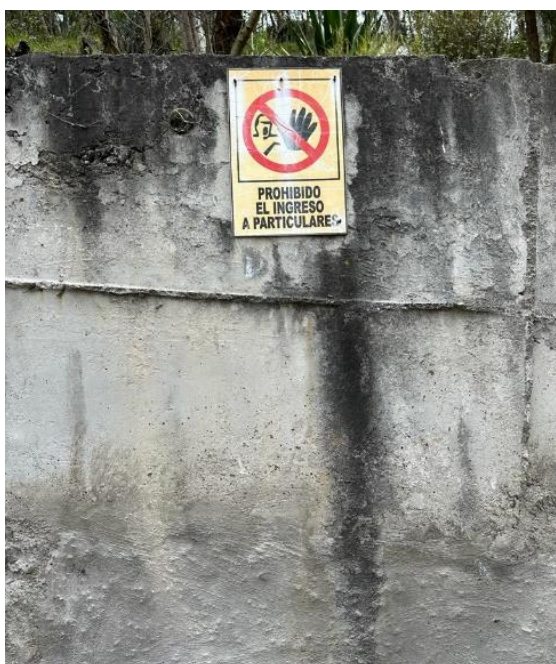
Figura 8. Señalética de la PTAR. Fuente: Autor
