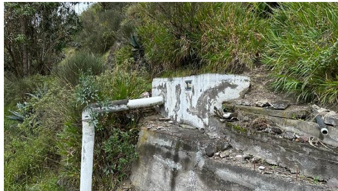
Figura 13. ByPass. Fuente: Autor
