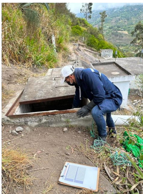
Figura 46. Medición del caudal de ingreso de la PTAR.
