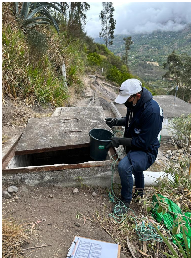
Figura 3. Medición de caudales.
