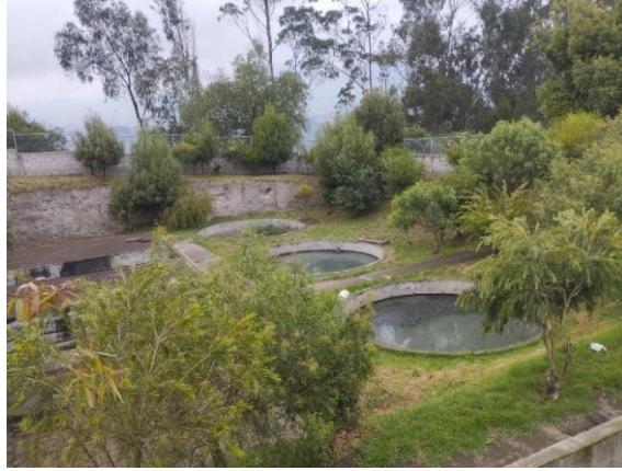
Figura 29. Filtro anaerobio de flujo ascendente (FAFA)
