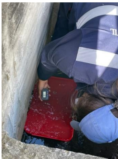
Figura 32. Medición de caudal de entrada de la PTAR
