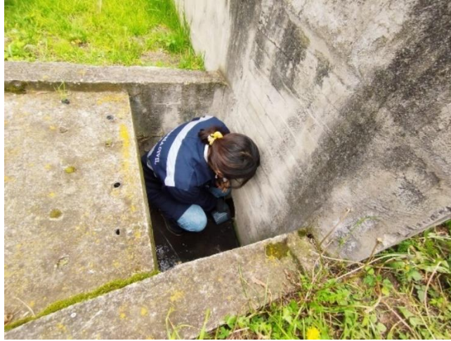
Figura 34. Toma de muestras de agua residual de entrada de la PTAR
