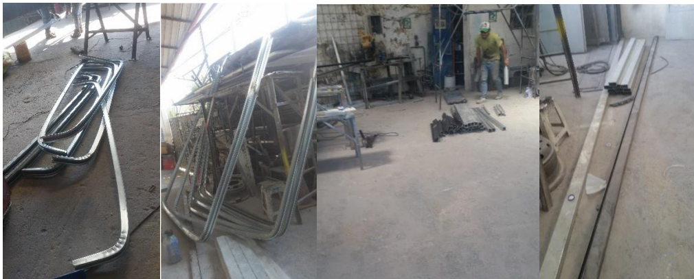
Fig. 7. Preparación de material para estructurado.
