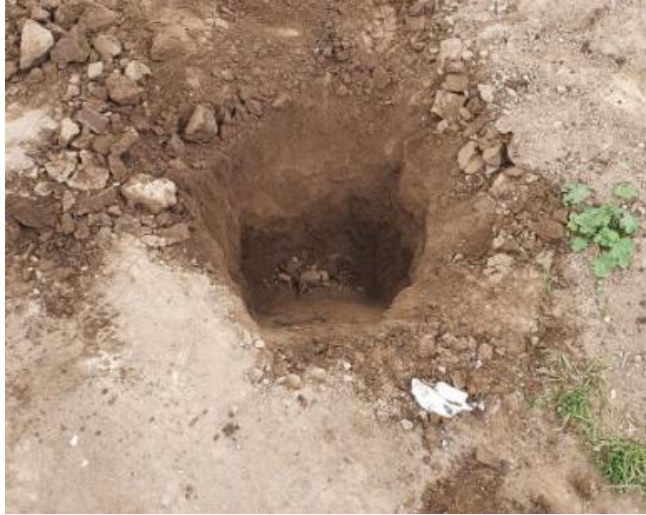
Calicata para muestra de suelo 60*60*1.56 “ASTM 1456”
