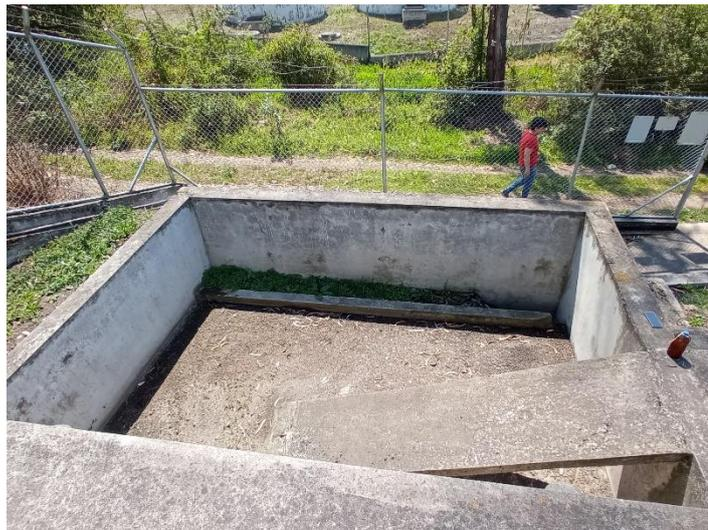
**Figura 11.** *Secado de lodos*
