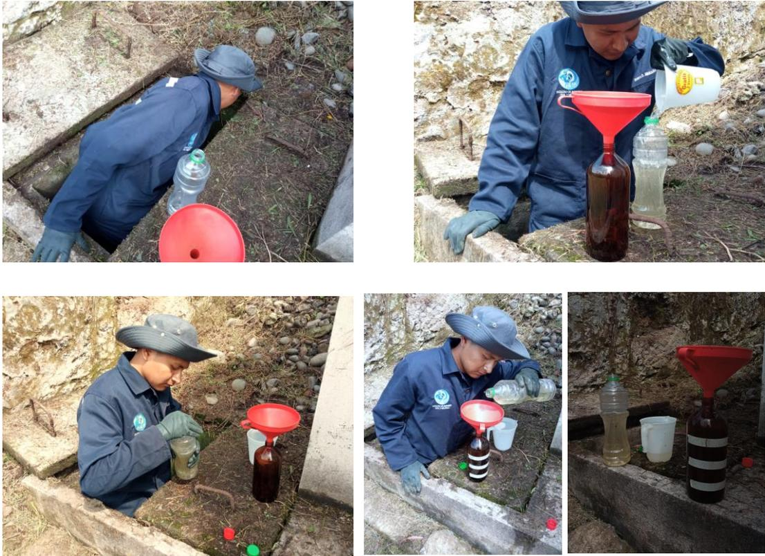
**Figura 25.** *Recolección de muestra de salida de agua residual de la PTAR*
