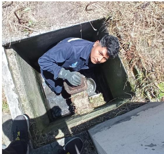
**Figura 23.** *Medición del caudal de salida de la PTAR*
