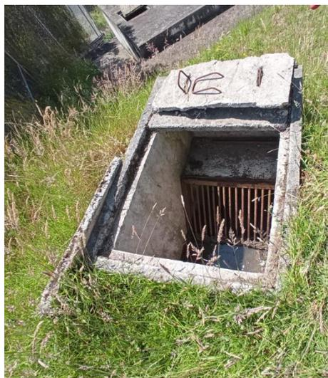
**Figura 8.** *Tanque repartidor*
