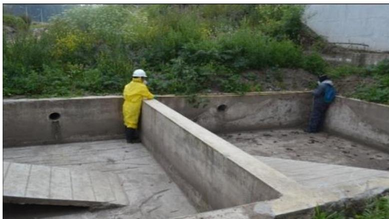
*Figura 16. Lecho de secado de lodos de la PTAR*
