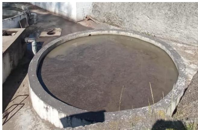
*Figura 14. Filtro anaerobio de flujo ascendente 1 de la PTAR*
