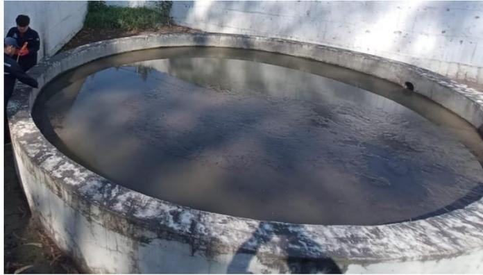
*Figura 15. Filtro anaerobio de flujo ascendente 2 de la PTAR*
