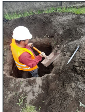
Excavacion de calicatas
