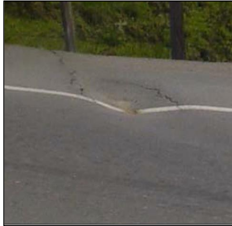
Figura 9: Hundimiento
