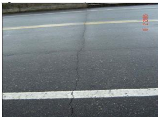
Figura 2: Fisuras Transversales
