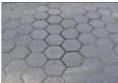
Figura 33: Juntas Abiertas
