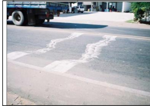
Figura 11: Ahuellamiento
