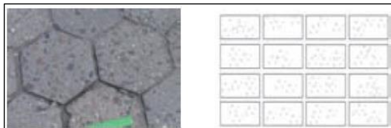
Figura 24: Desgaste Superficial
