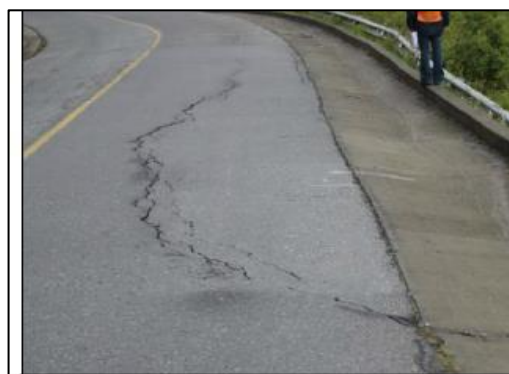
Figura 3: Grietas Parabólicas
