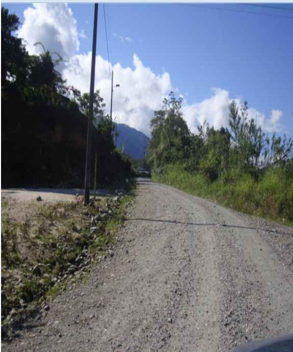
a.- Vía lastrada
