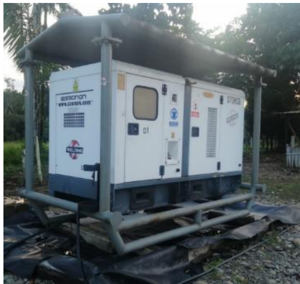
Fig. 12 Colocación sobre cubetos
