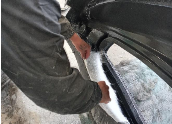
Figura 17 Aplicación de la fibra de vidrio
