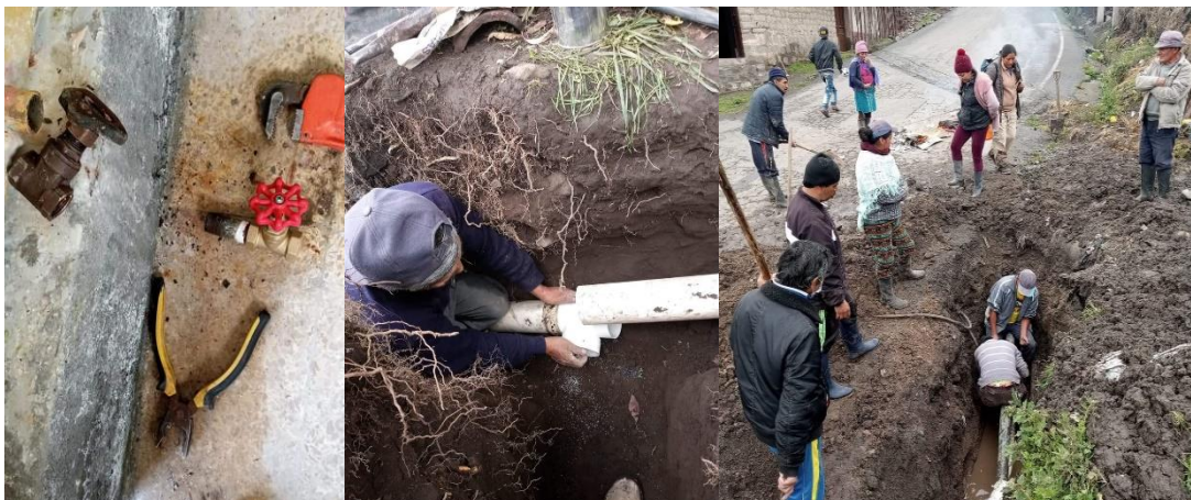
Imagen N.- 21: Operaciones de mantenimiento correctivo
