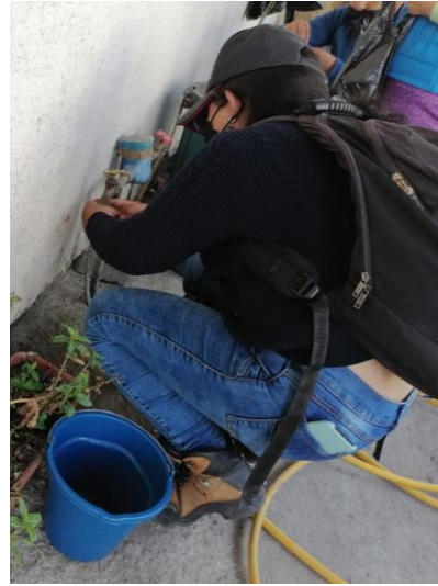
Conexión del manómetro en el punto de agua más cercano a la acometida domiciliaria.
