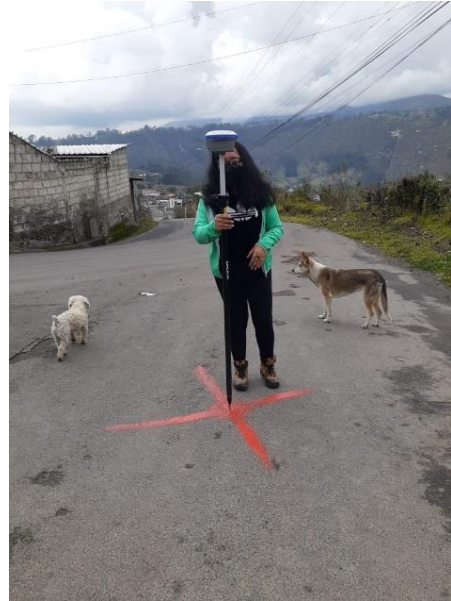
Toma de los puntos de control.
