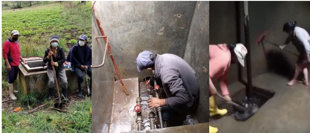
Imagen N.- 20: Operaciones de mantenimiento
