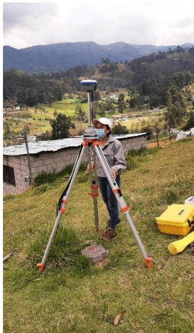
Implantación del equipo topográfico (RTK Chcnav i90).
