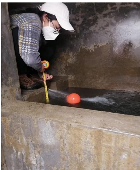
Medición del tanque rompe presión existente.
