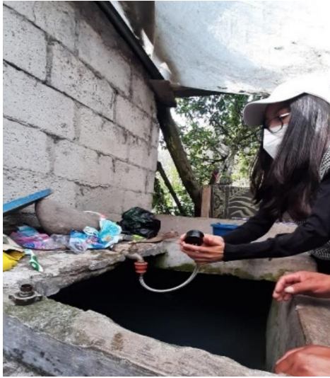
Medición de la presión en las acometidas domiciliarias.
