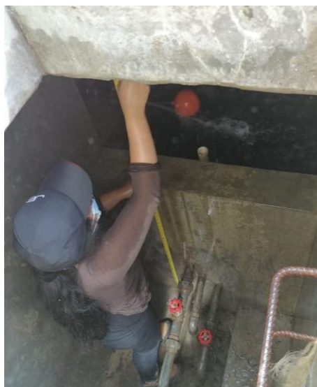
Verificación del estado de la infraestructura del tanque rompe presión existente.
