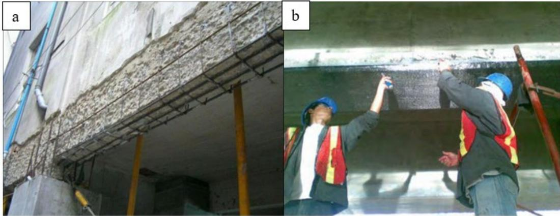
**Figura 1.4** Tipos de reforzamientos a nivel de elemento a) encamisado de concreto b) FRP [22], [24].
