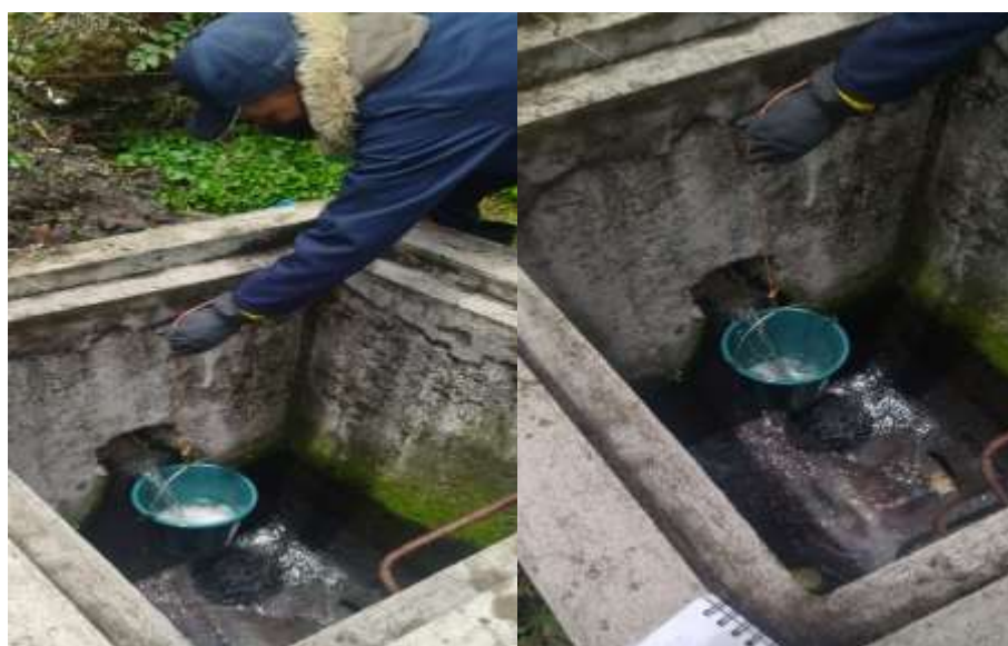
Figura 11. Toma de caudales del efluente de la PTAR
