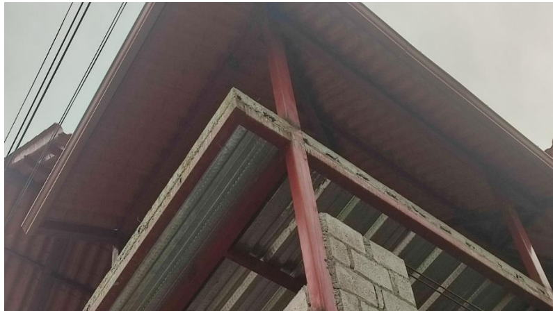
Imagen N° 1. Conexión viga columna del sistema analizado.
