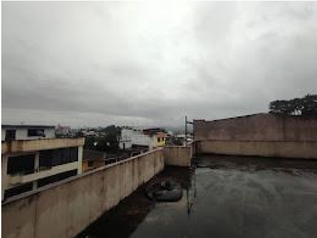
Anexo 19. Levantamiento fotográfico del área de estudio (Edificios Residenciales) Fotografía del autor 2022
