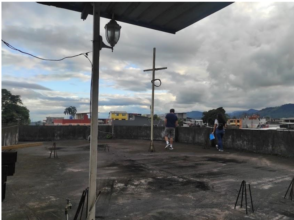
Anexo 20. Levantamiento fotográfico del área de estudio (Edificios Residenciales) Fotografía del autor 2022
