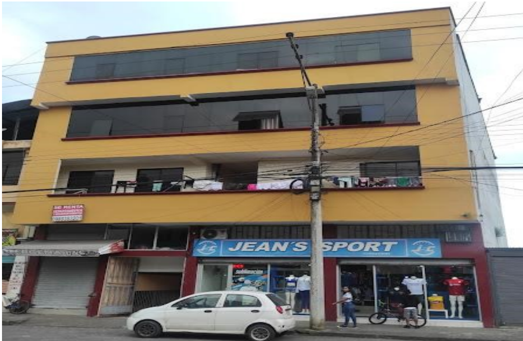
Figura 43. Edificio Residencial zona 7 Jean Galarza Fuente: Fotografía del autor 2022
