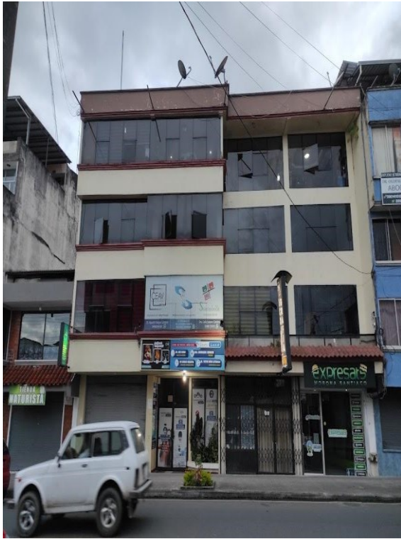
Anexo 9. Edificio Residencial zona 7 Tarsicio O. Fotografía del autor 2022
