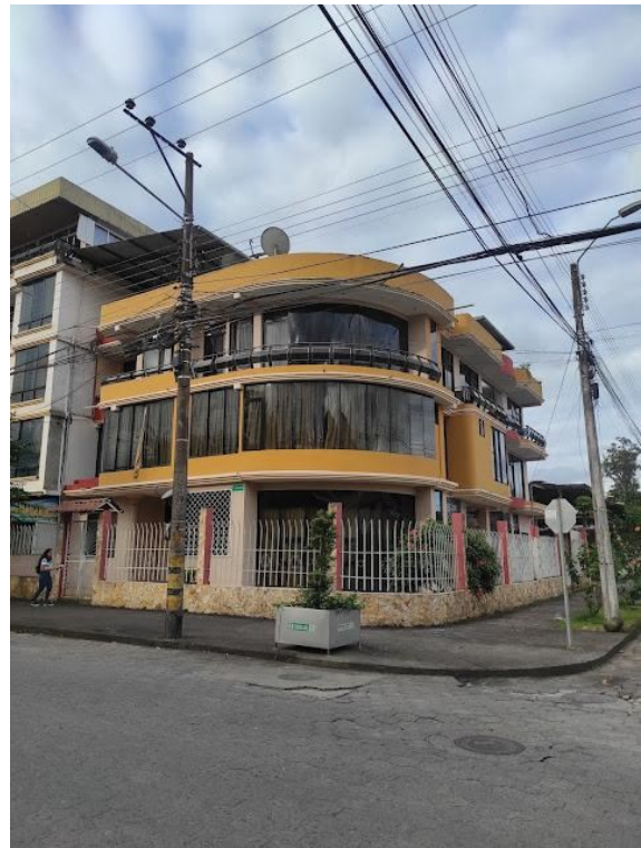
Anexo 2. Edificio Residencial zona 6 Juan Sinchi Fotografía del autor 2022
