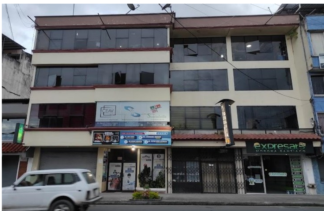
Figura 45. Edificio Residencial zona 7 Tarsicio Ojeda.
