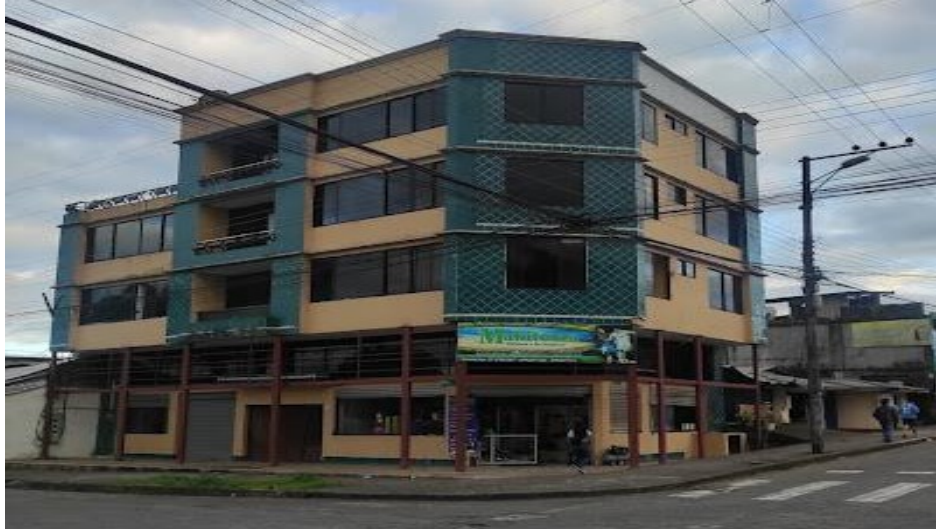
Figura 41. Edificio Residencial zona 6 Jasón Vera. Fuente: Fotografía del autor 2022
