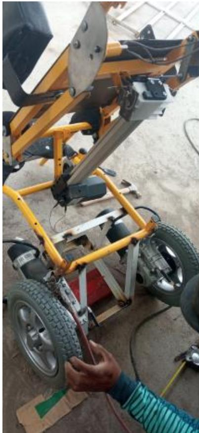
*Figura 74. Soldadura en el eje inferior para la inclusión de baterías*
