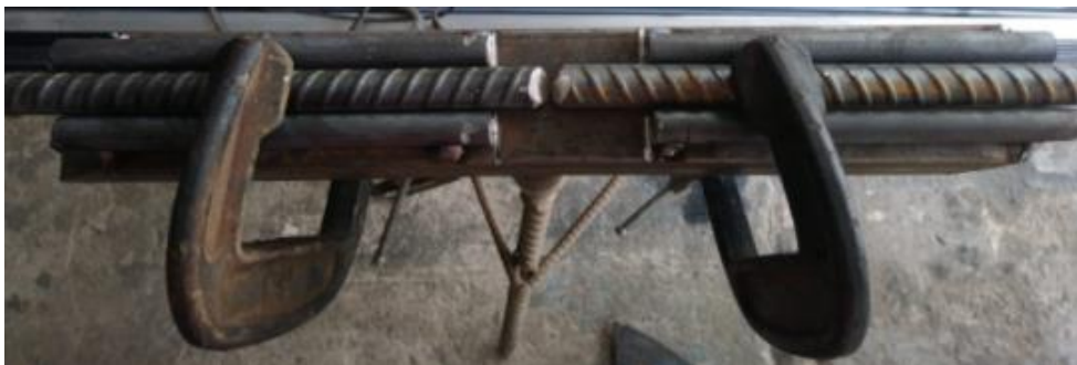
Figura 12: Soporte para soldar varillas de acero de refuerzo.
