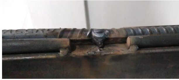
Figura 24: SMAW junta a tope con bisel en V doble – pase #7 y resanado.
