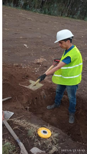
Fotografía 2 Pozos a Cielo Abierto
